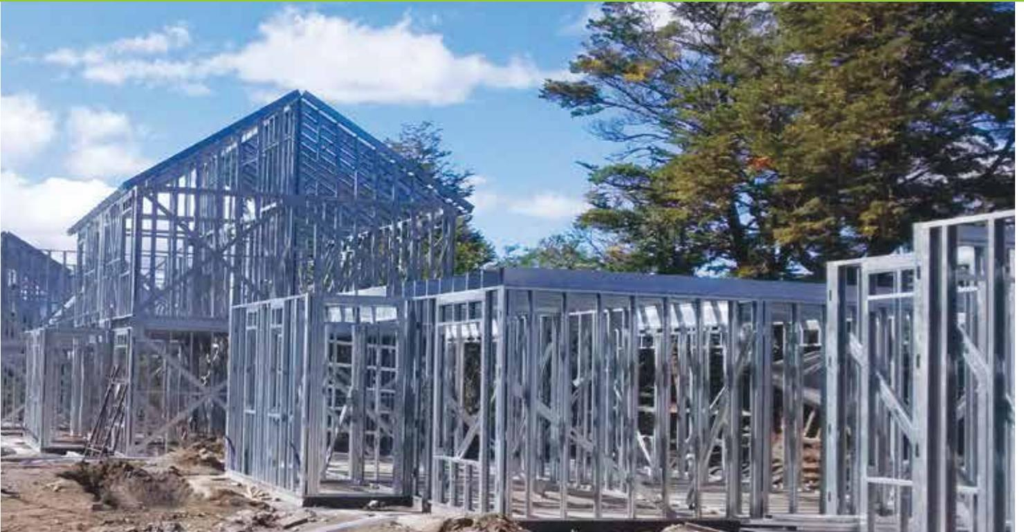
El sistema constructivo **STEEL FRAMING** está compuesto por perfiles de acero galvanizado livianos conformados en frío, para distintas aplicaciones estructurales como tabiques, entrepisos y cubiertas.
